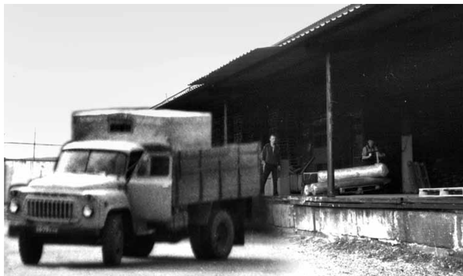
В 1960-е годы началось строительство Красноярской оптово-торговой базы крайпотребсоюза
